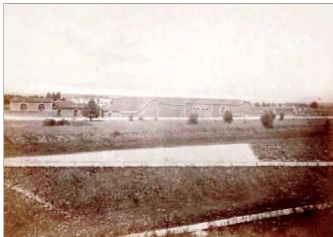
Fort odosobniony przed frontem Księcia Warszawskiego – stan z 1884 r.
