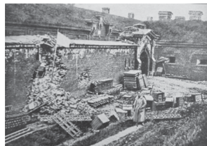
Fort-III (Pomiechowo) – część szyjowa fortu (po lewej mur Carnota z bramą, a po prawej kaponier szyjowa – za murem widoczne koszarzy szyjowe); zdjęcie z 1915 r.
