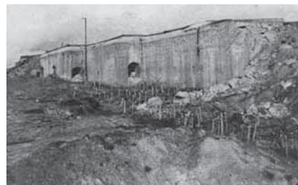
Punkty oporu prawej flanki grupy fortu XV (GF-Carski Dar) – tradytor do ostrzału międzypola w kierunku fortu XVI (Czarnowo)
