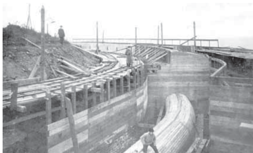
Budowa rosyjskiego fortu piechoty po 1912
