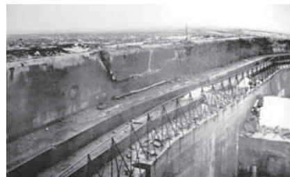
Punkty oporu prawej flanki grupy fortu XV (GF-Carski Dar) – stanowiska piechoty
