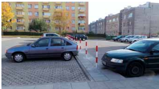
Zmodernizowany parking przy ul. Moniuszki
