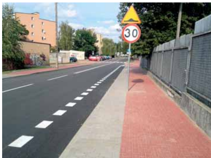
Zmodernizowana ul. Inżynierska
