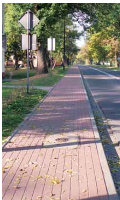
Wyremontowane chodniki przy ul. Chrzanowskiego
