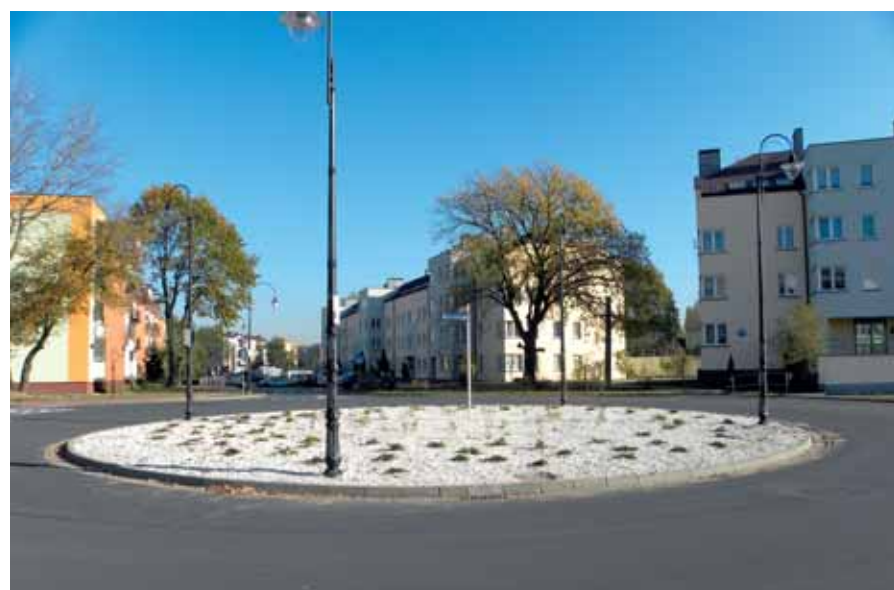
Przebudowane rondo przy ul. Młodzieżowej. Ustawiono nowe latarnie i wykonano nasadzenia
