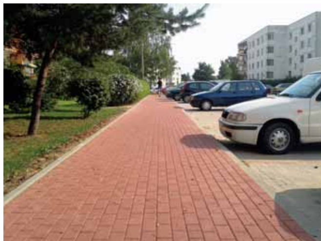
Nowe chodniki w ul. Okulickiego
