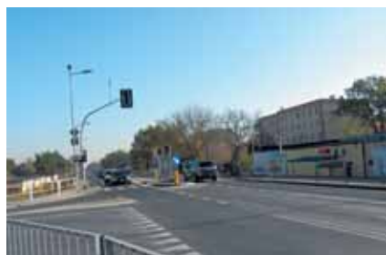
Przebudowana ul. Leśna i Wojska Polskiego
