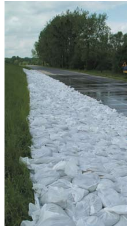
WAŁ WZMOCNIONY WÓRKAMI Z PIASKIEM 25.05.2010 R.
