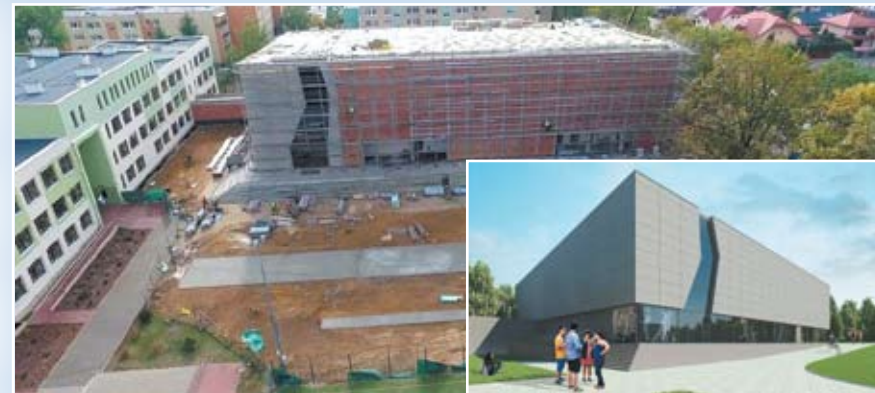
WIZUALIZACJA HALI NA OSIEDLU MŁODYCH ORAZ POSTĘPY W BUDOWIE
