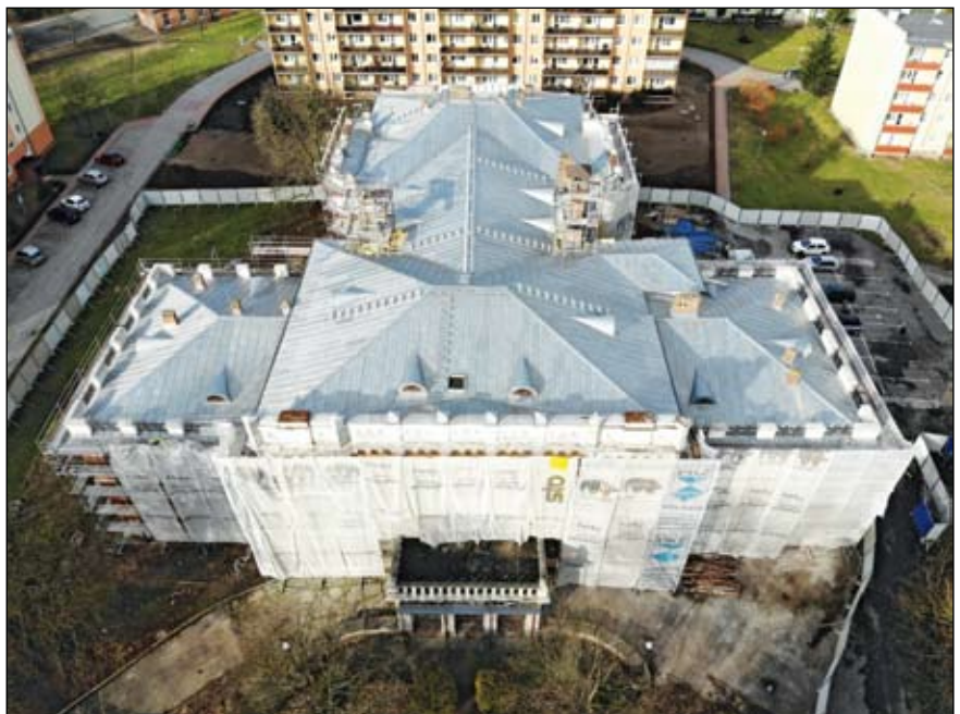
DACH GKO PO REMONCIE
