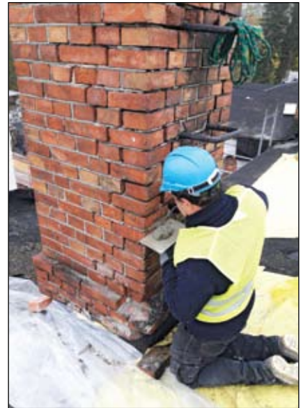
PRACE PRZY KOMINIE
