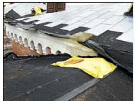
PRACE PRZY KOMINIE
