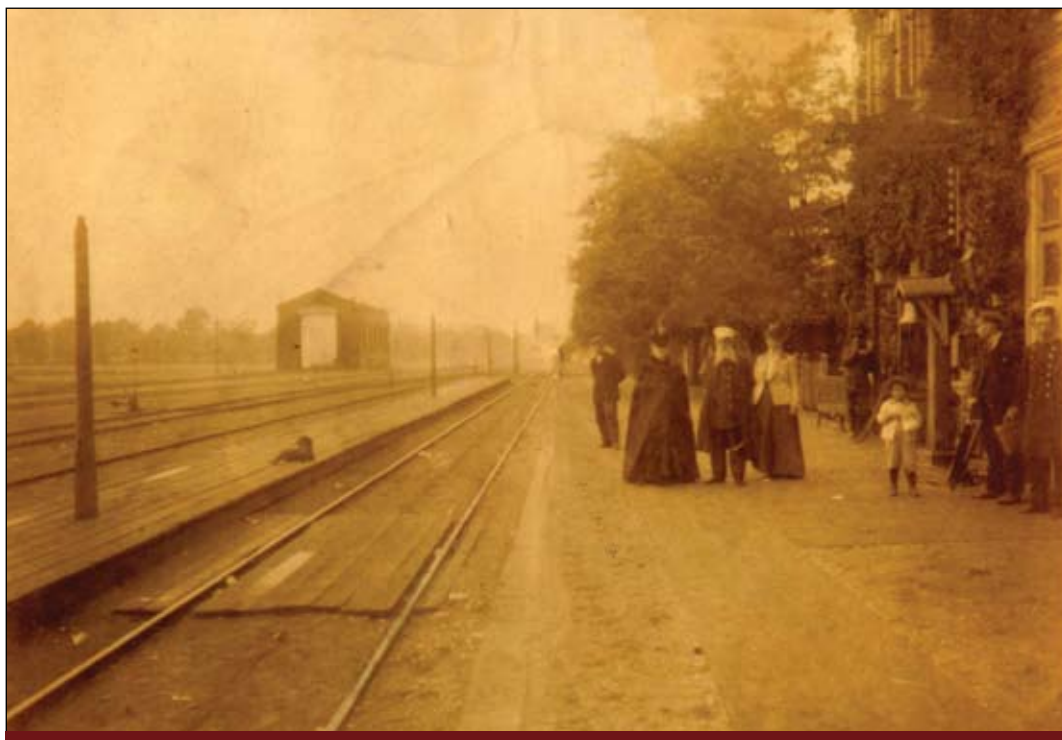
Do katastrofy doszło przed stacją kolejową w Nowym Dworze
